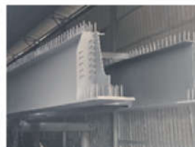
轨交钢结构腐蚀防护
