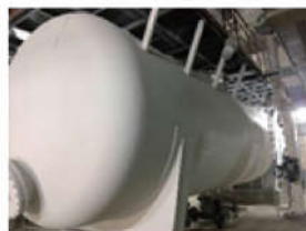
储罐隔热保温防护
