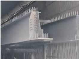
轨交钢结构腐蚀防护
