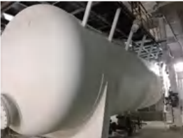
储罐隔热保温防护
